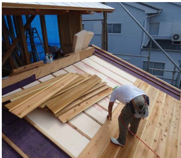
断熱材の上から 15mm 厚の杉板を施工
