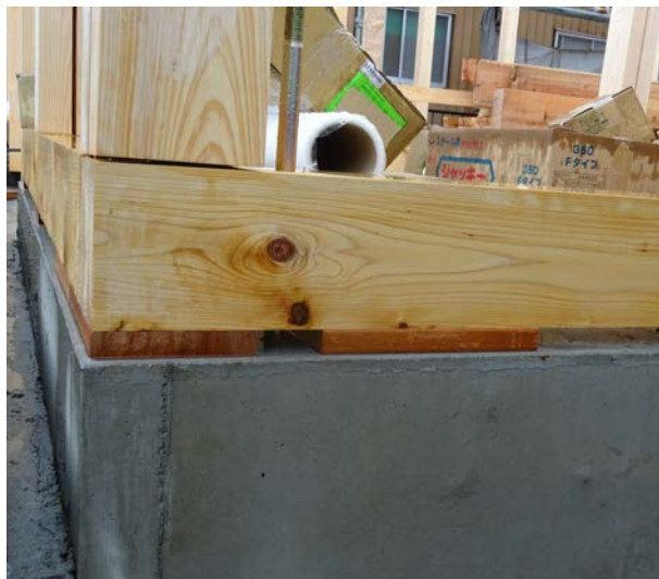
土台の能登ヒバ 基礎パッキンにはユーカリ材
