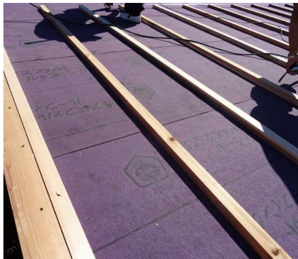
野地垂木を 455mm ピッチで取付け
